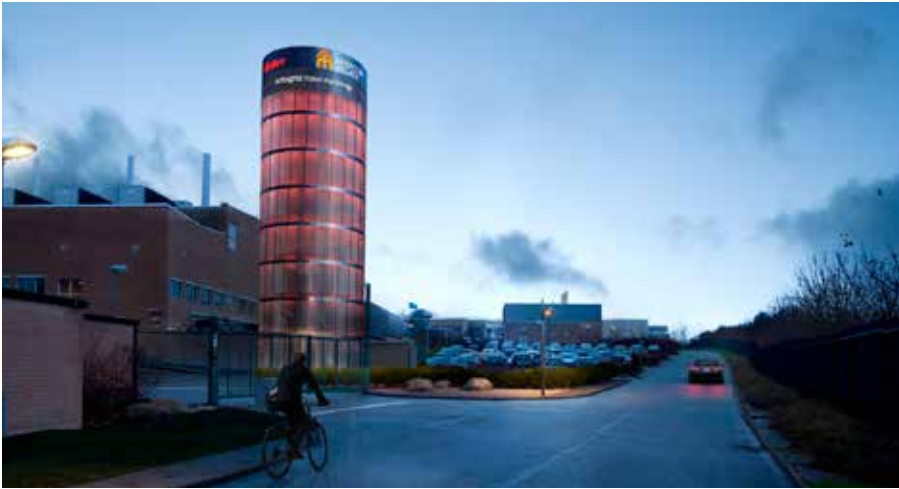
Systemet Ectogrid i Medicon village i Lund är ett exempel på femte generationens fjärrvärmenät...
